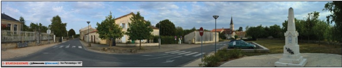
1 - SITUATION EXISTANTE - (© Mairie d'Aubigné) - Vue Parasatique 180°
